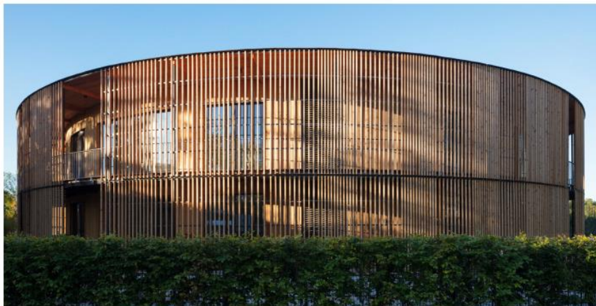
Kindergarten in Freiburg, Ingenhoven Architekten
